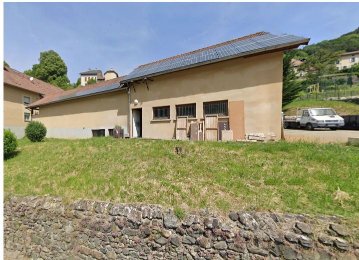
Proposition de zonage : l'ensemble du patrimoine bâti sur la commune
