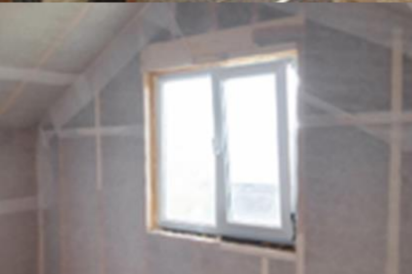
2. Photo : Frein-vapeur correctement posé
